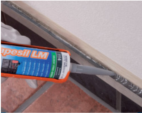
Σφράγιση λίθινων επικαλύψεων σε εσωτερικούς χώρους
