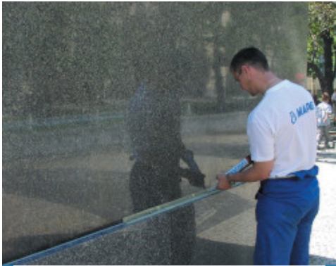
Σφράγιση αρμών σε πρόσοψη με Mapesil LM
